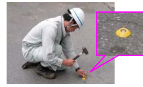
<幅杭の設置状況(イメージ)>
