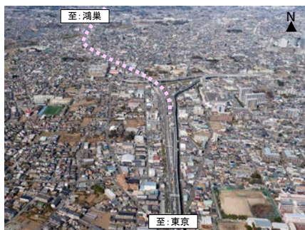
与野JCT(仮称)付近
