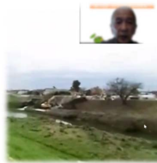
砂川樋管の質疑応答
