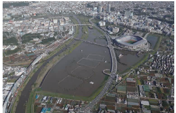
出水時 平成26年10月
