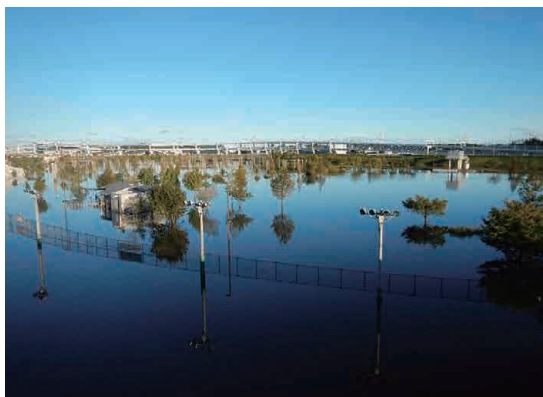
約94万m 3 を貯留した鶴見川多目的遊水地 令和元年10月13日 6時30分頃
