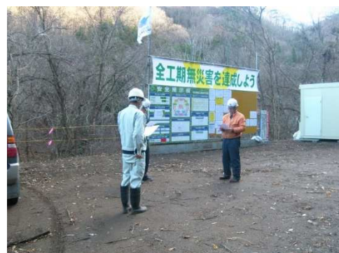
現場での打ち合わせ状況
