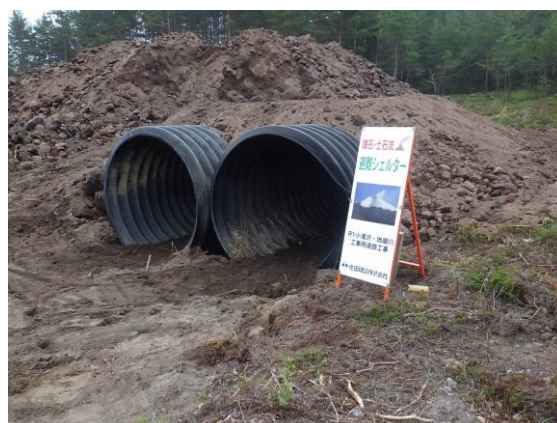
写真-8（噴石・土石流シェルター）
