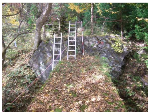
高低差の有る箇所に梯子の設置
