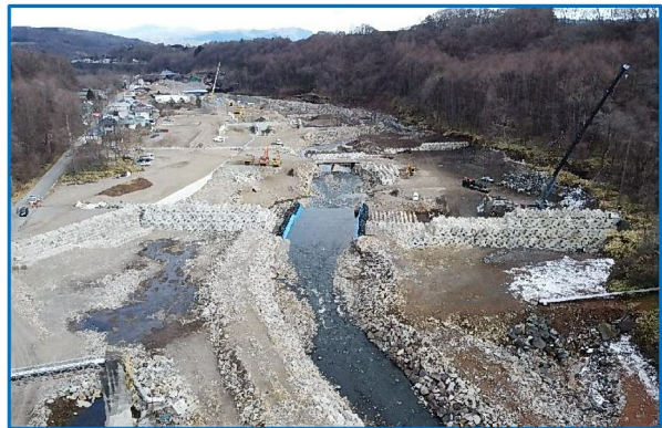
写真-2 令和2年12月下旬 上空上流より
