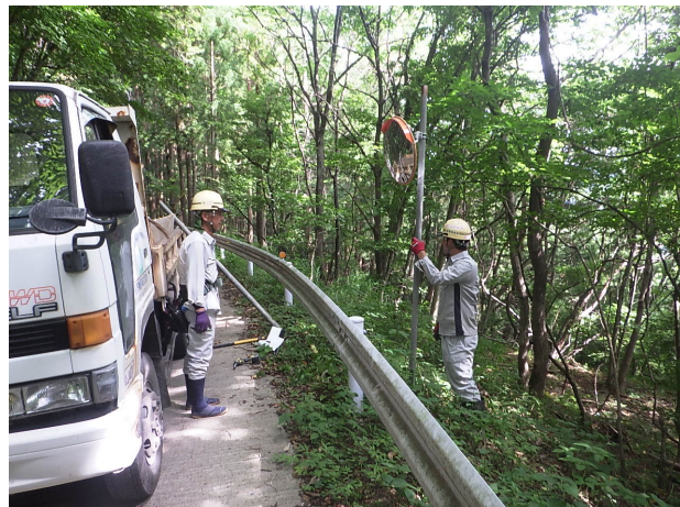
カーブミラー設置設置
