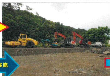
重機退避完了(出水前)
