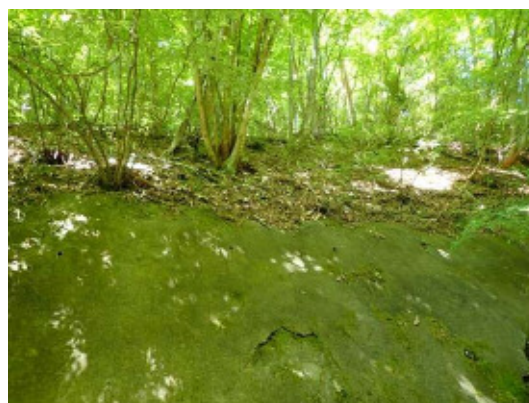
現地で確認した危険斜面
