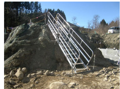
階段設置状況
