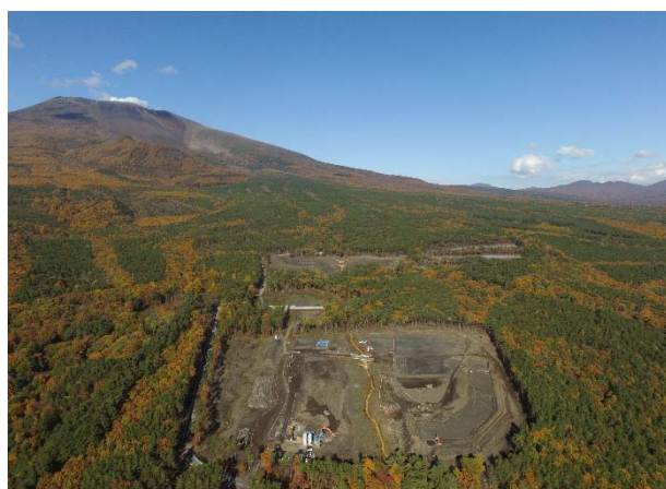
写真-2 南麓側管内（長野県側）
