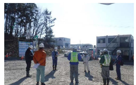
写真－１３ 安全パトロール状況
