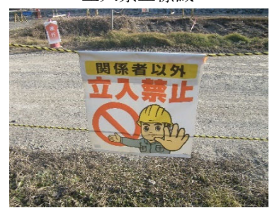
立入禁止標識
