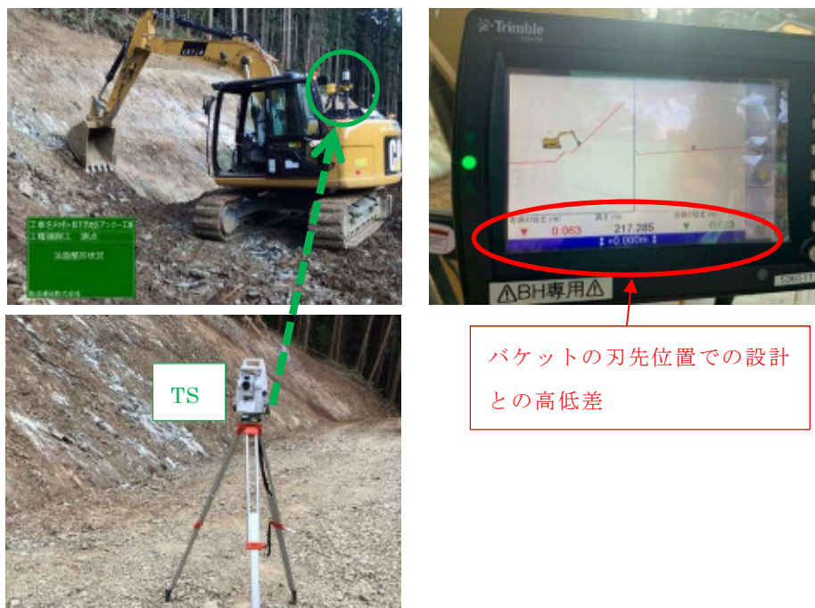
I C Tバックホウによる作業写真
