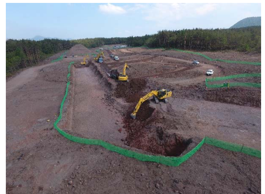
写真-4 地蔵川第二砂防堰堤施工状況
