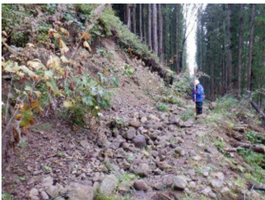
図 3 サク沢の土石流堆積物
