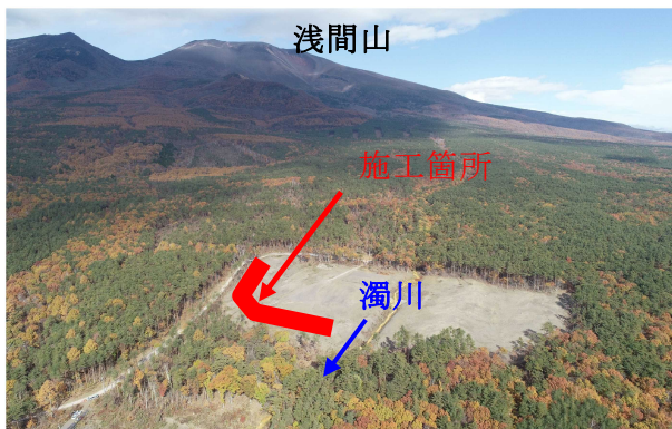
写真-1-1 施工箇所全景写真(令和1年10月)
