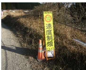
速度制限標識
