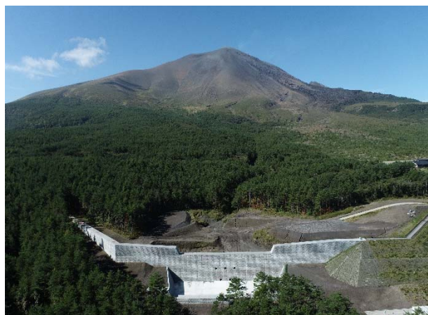
写真-1 北麓側管内（群馬県側）
