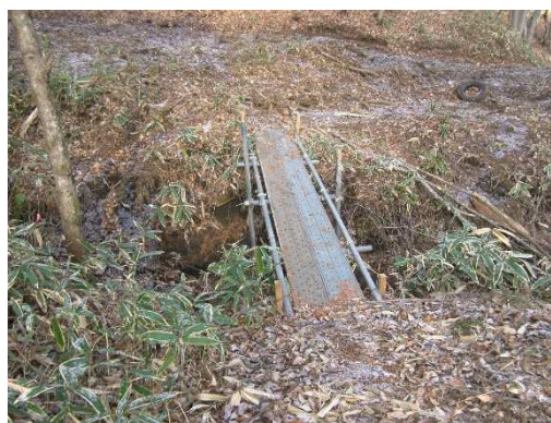
流水で溝が出来ている箇所道板の設置
