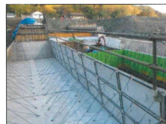
先行手摺り設置状況
