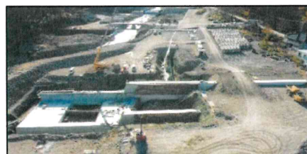
床固工施工状況(11月上旬)
