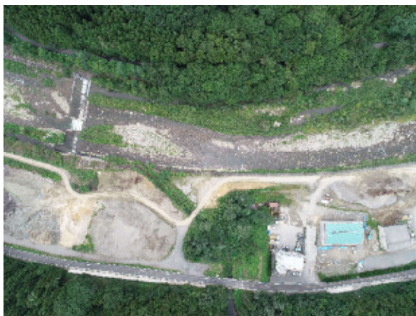
摺溜床固群 ドローン撮影写真
