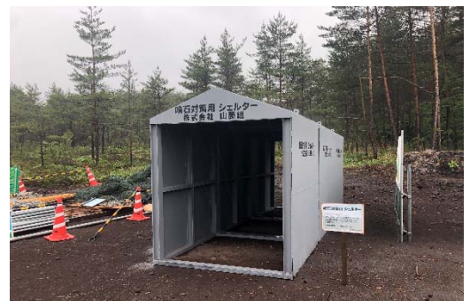
写真-8 噴石シェルター（地蔵川第二）
