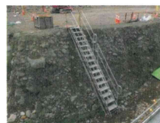
昇降設備設置
