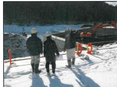
地域の皆様への工事説明
