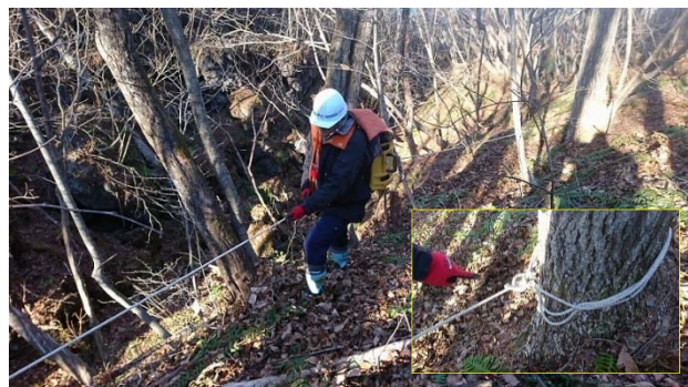
【写真10 ロープ張による安全対策】
