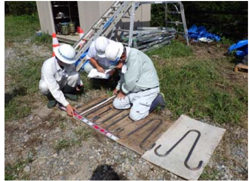
写真－２ 材料確認 (R 1 越本床固群外整備工事)
