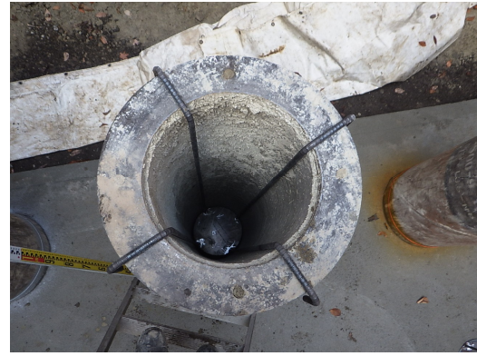
ハツリ用専用蓋設置
