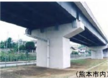
写真-3 国道3号 跨線部
