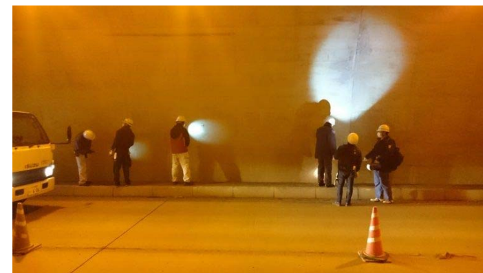
点検実習(打音点検・クラック調査)
