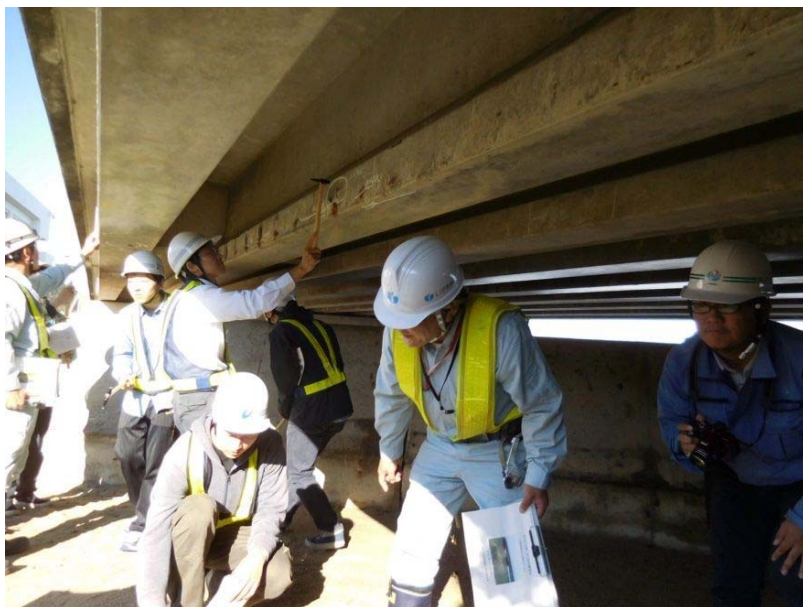
打音検査状況
