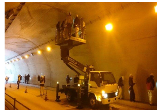
【現地での点検実施状況】
