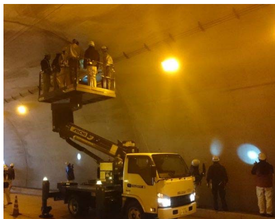
高所作業車による近接点検
