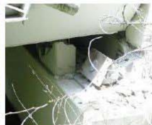
写真-2 支承部の損傷に伴う桁端部の浮き上がり (県道熊本高森線・桑鶴大橋)
