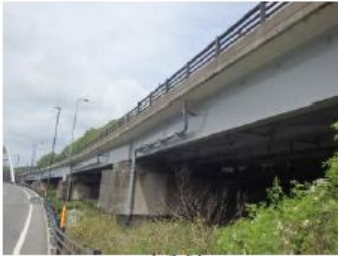
写真-4 阿蘇口大橋 (国道57号)
