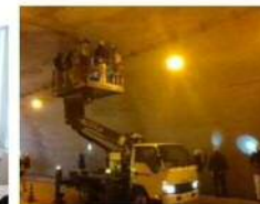
高所作業車による近接点検
