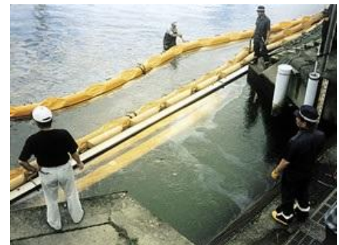
オイルフェンスの設置
