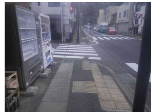
▼ボラード設置例 (吉倉地区)
