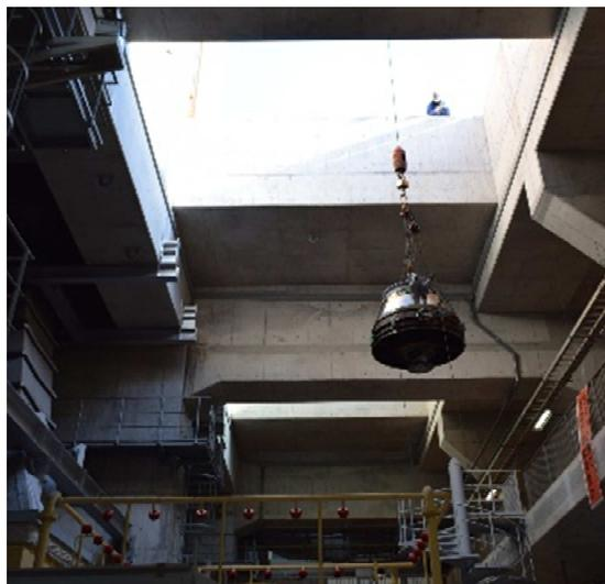
庄和排水機場の地下から大きなクレーンを使用して排水ポンプのパワータービンを搬出します。壁などにぶつからないよう、慎重に運びだします。
