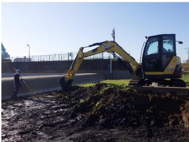
倉松川流入施設に堆積している土砂を撤去しています。土砂の撤去後に施設に異常が無い点検を行います。(1月に完了しました)
