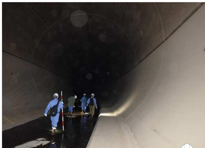
職員による目視でのトンネルの点検を実施しました。トンネル内に異常がないか、ライトと計測に使用する機材を持って歩いて点検しました。
