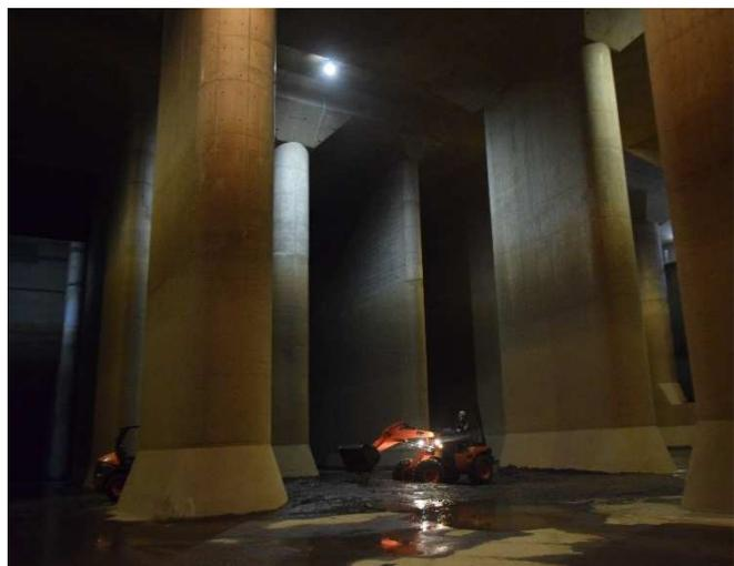
調圧水槽の土砂撤去の状況です。作業の完了後は、床面や柱の状況の点検を行います。
