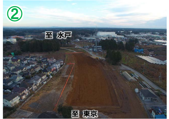
東田中周辺の工事状況
