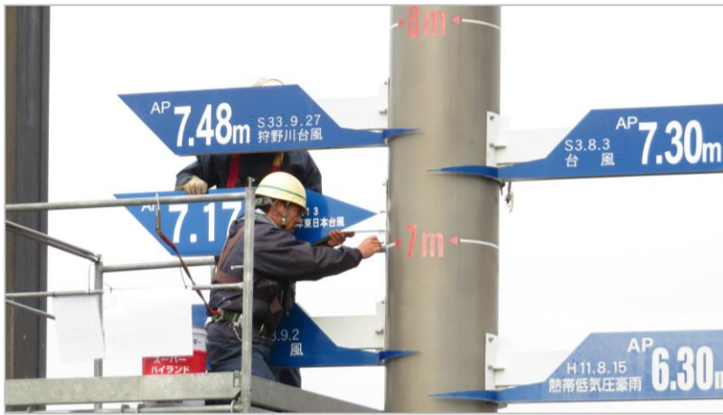
▶設置作業の様子
