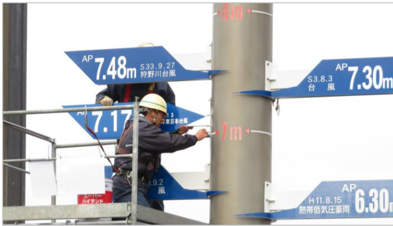
▶設置作業の様子
