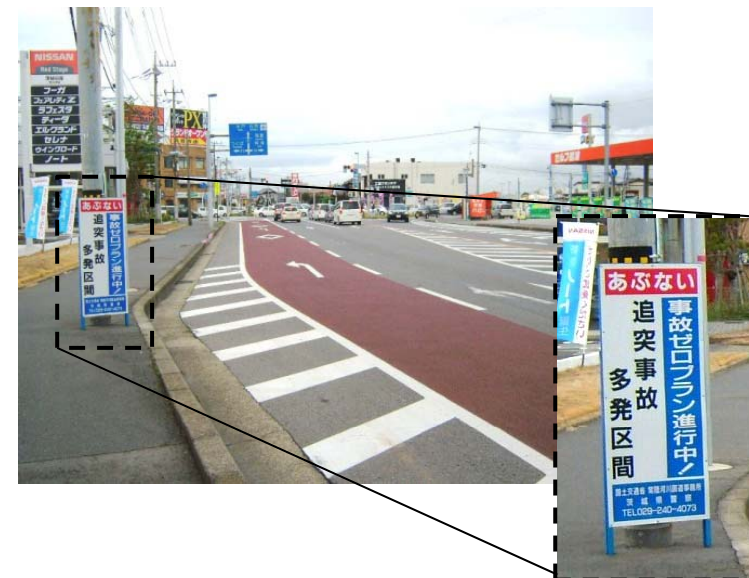
国道6号学園東大通り入口交差点における設置例 （追突事故多発区間の明示）
