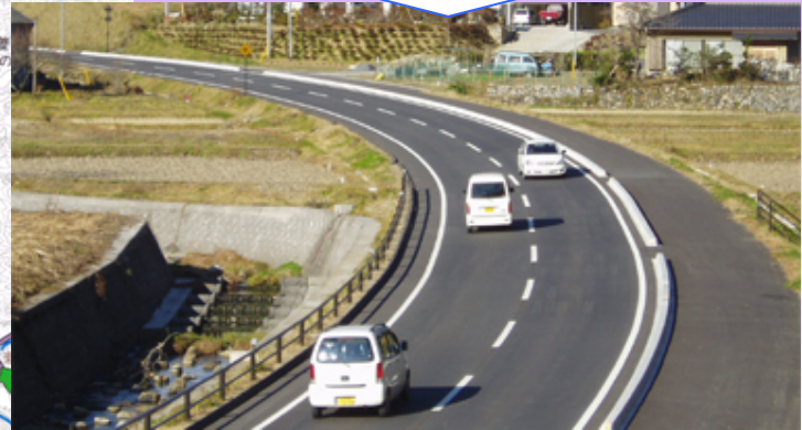
常陸太田市上高倉町 (対策後)
