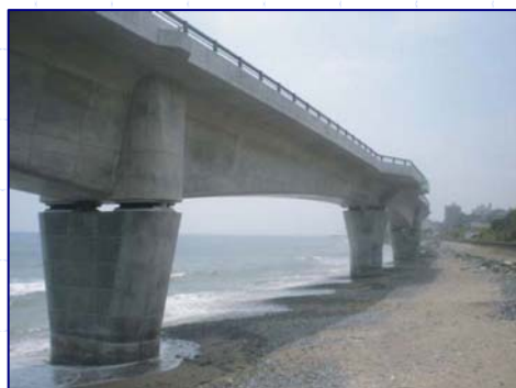
海岸部の橋梁(旭町方面を望む)
