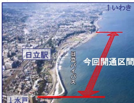
日立バイパスの今回開通区間
