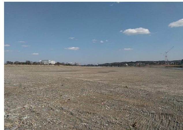
完了(令和3年3月撮影)
