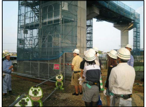
【現場見学状況①】
