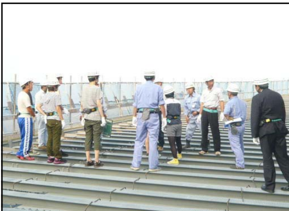
【現場見学状況②】
