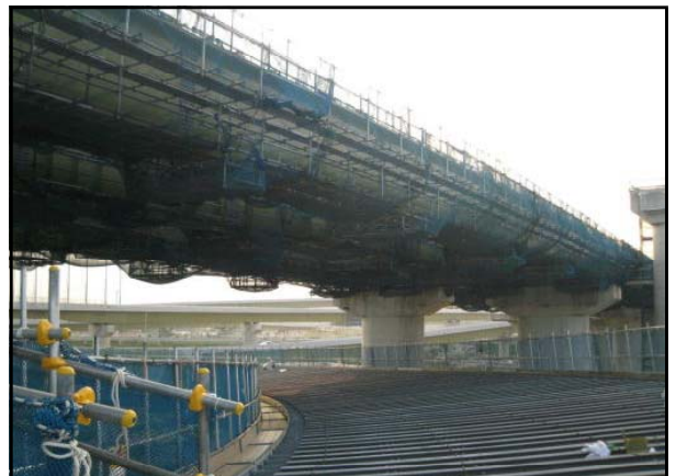
【工事現場の状況】
