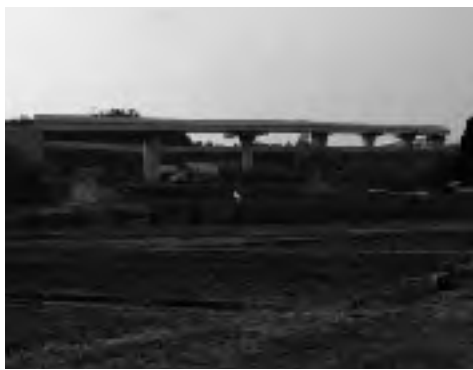
③ 橋梁工事が進む木更津ジャンクション
