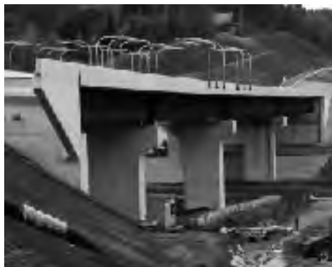
⑤ 上部・下部工事とも完成した上宮田橋
