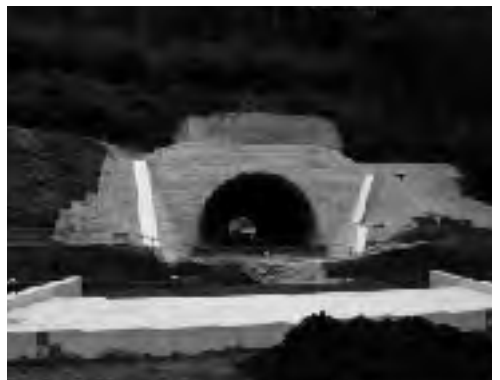
⑧ 貫通した真里谷第3トンネル
