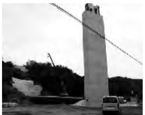
⑨ あてび 当日の橋梁工事
