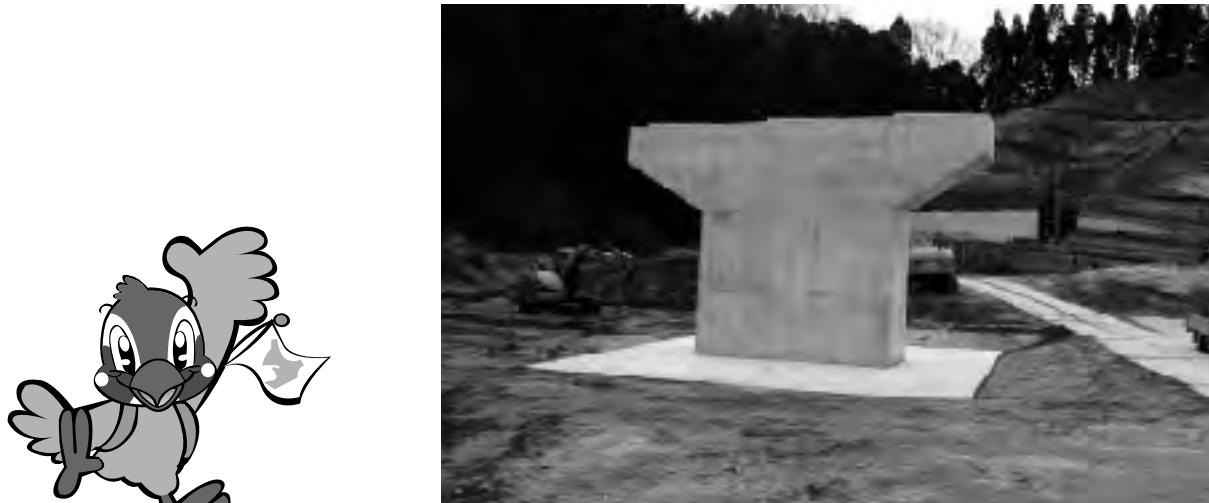
●長南町坂本地先の橋梁工事
