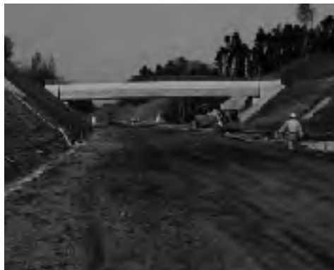
④ 跨道橋工事を終えた木更津市笹子地区
