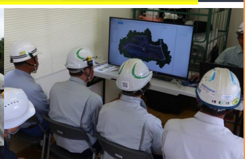
UAV(エブリデイトローン) による日々の出来形 管理実施状況の見学
