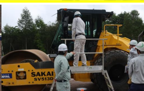
ICT振動ローラーによる 盛土の締固め管理 実施状況の見学
