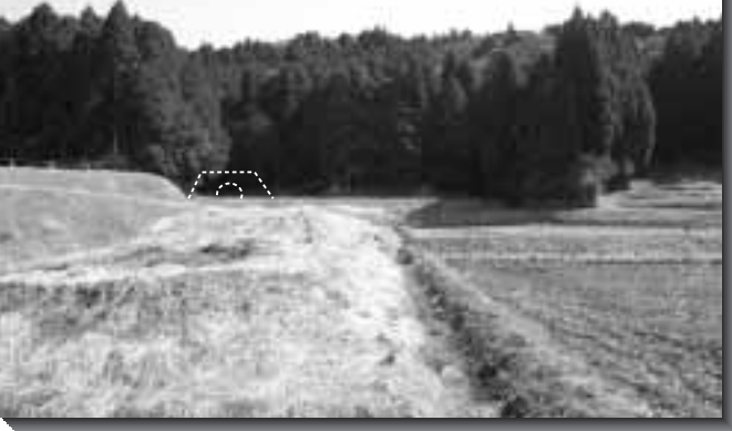
●着工前の真里谷第4トンネル坑口(平成16年3月撮影)
