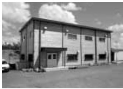
●圏央道インフォメーション館外観
