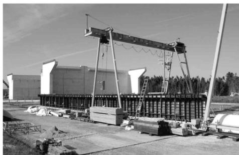
●完成した七曲川橋の橋台付近で、コンクリート桁の製作を進めています。
