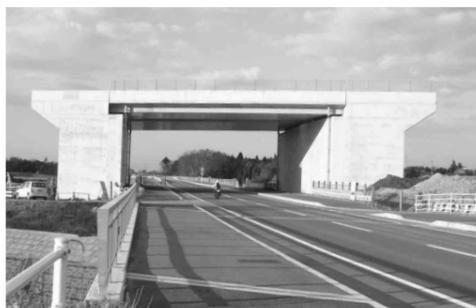
●国道410号バイパスを通過する部分では、橋げたの架設工事が終わっています。
