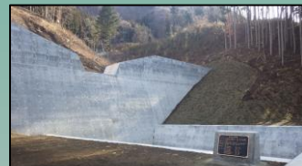
H29柿平沢砂防堰堤工事
