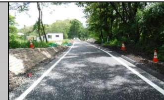
H29浅間南山麓工事用道路工事
