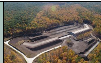
H29濁沢第二砂防堰堤(本堤)工事
