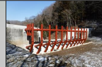
H30品川流域砂防整備工事
