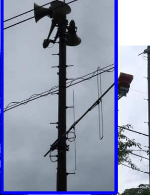
サイレン吹鳴
