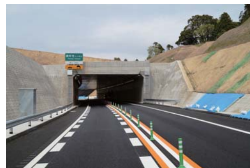
養安寺トンネル
