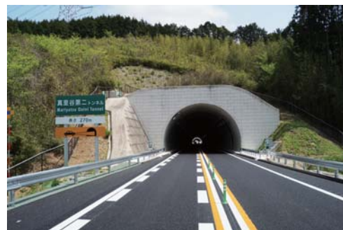
真里谷第二トンネル
