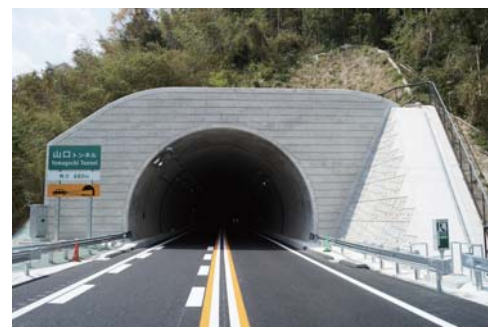
山口トンネル
