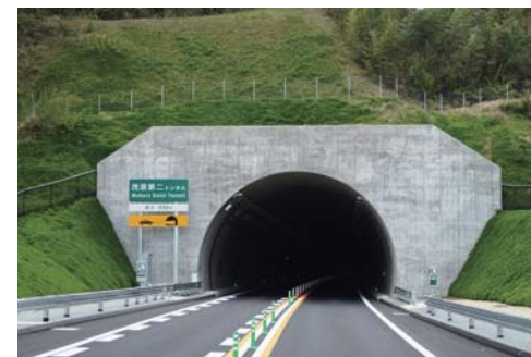
茂原第二トンネル
