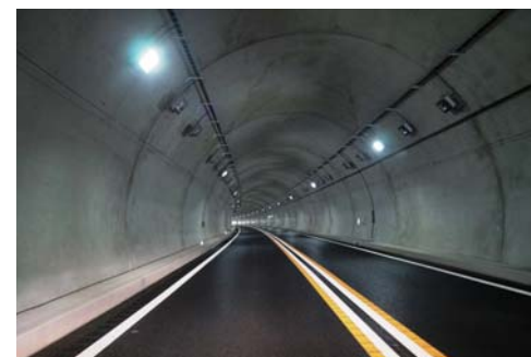
山口トンネル内
