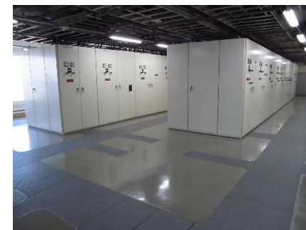
電気室 (保守・更新スペースの確保)
