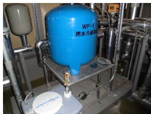
雨水利用設備
