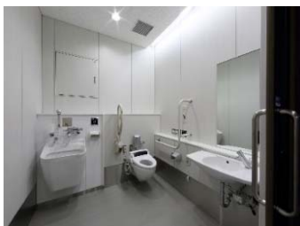
多機能便所の設置 (地上の各階設置)
