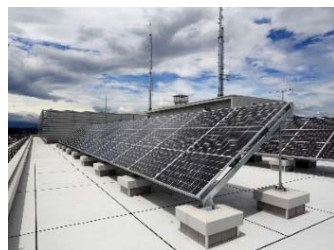
太陽光発電設備
