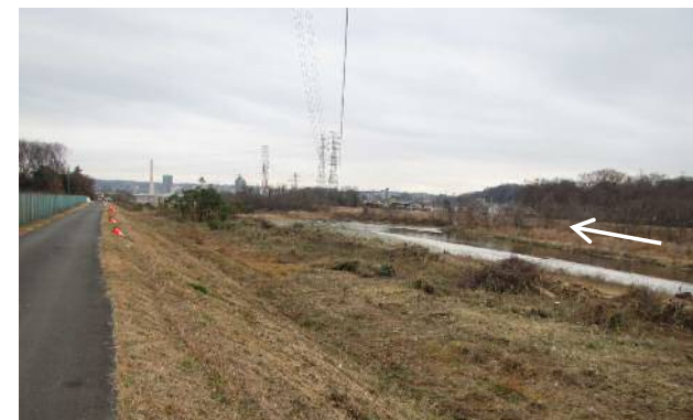
施工中(令和3年1月15日撮影)
