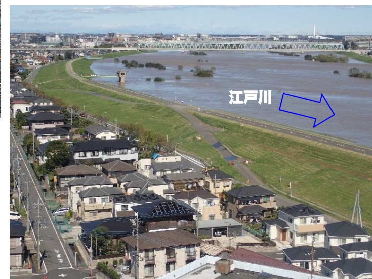
令和元年10月台風19号洪水状況(埼玉県三郷市付近)
