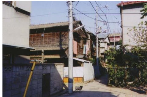
整備前は木造住宅等が密集し、道路整備が遅れ、生活環境が悪化
