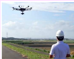
ドローンを活用した測量作業状況
