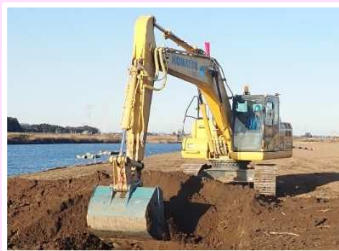
ICT建機による河道掘削
