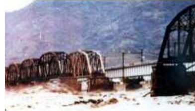
東海道本線鉄橋の流失
