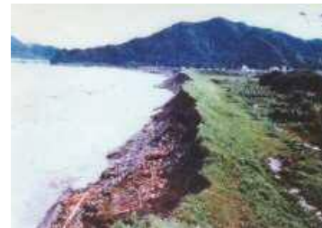
身延町波木井地先の堤防洗掘
