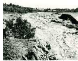
笛吹川左岸の堤防の決壊
