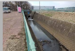
砂川堀雨水幹線
