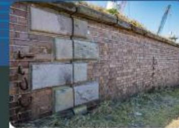
右翼北側の掩蔽壕の外観です。イギリス積み風の煉瓦が114m続き、煉瓦は高温で焼いた耐水効果の高いものが使われています。
