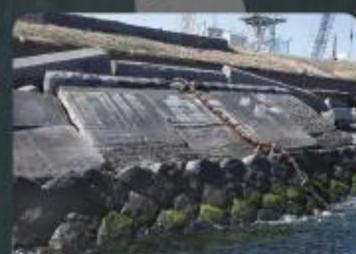
間知石が積まれた南側の護岸です。伝統的な築城技術によるもので、関東大震災でも崩壊しなかった堅固な構造となっています。
