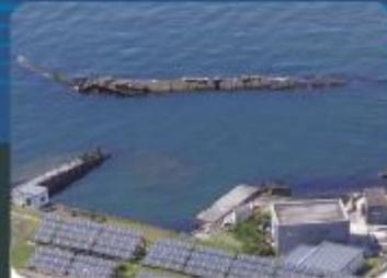
北側海域の防波堤です。東側は延長160m、西側は延長80mですが、西側部分は沈下が進み海没状態です。
