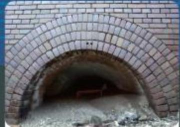
右翼北側の掩蔽壕の内部です。アーチ形の入口は地下通路で27cm加農砲に繋がり、天井はコンクリート、機壁は煉瓦構造物となっています。
