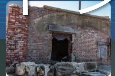
北側の繋船場に隣接する倉庫です。壁は煉瓦、天井はコンクリート。繋船場に近い場所に位置し、防水施工もされており、燃料を保管した倉庫であると考えられています。
