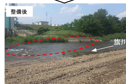
旗川 河道掘削状況(中州除去)
