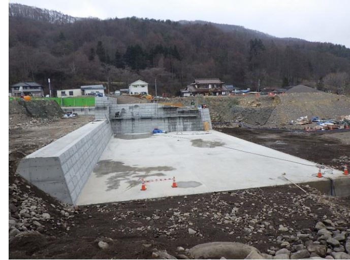
左岸下流側から垂直壁工を望む
