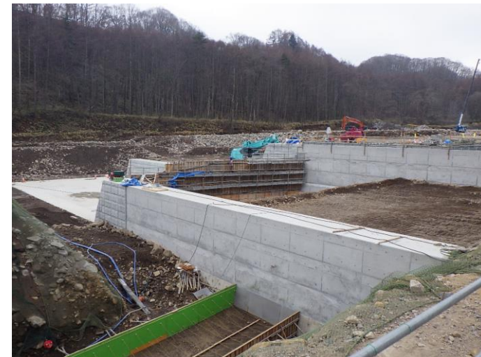
左岸下流側から垂直壁工を望む
