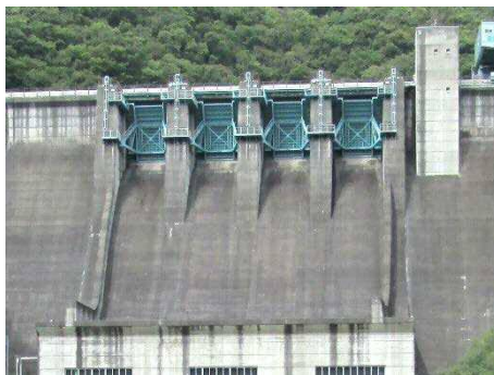
クレストゲート (非常用放流設備)
