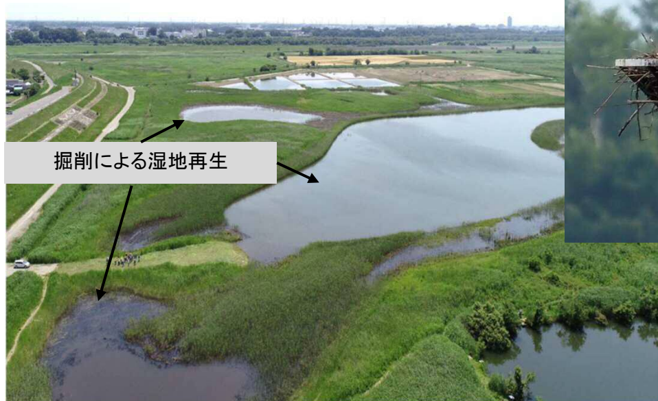
渡良瀬遊水地(第2調節池)の掘削
