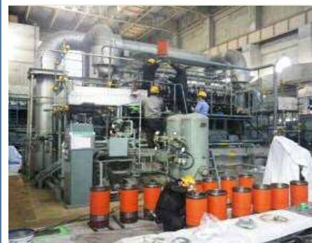
機械設備の点検
