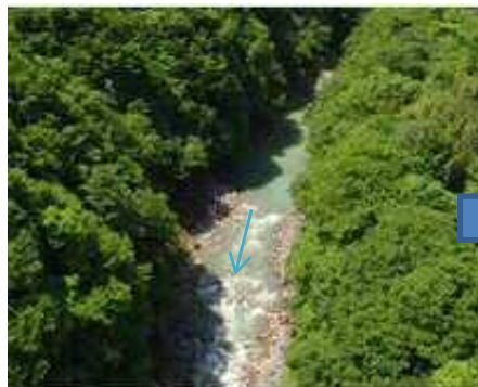
ダム完成前(補給なし)の状況 (平成28年5月29日)
