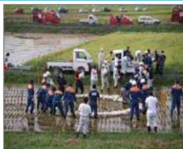
群馬県明和町漏水状況 (H19)
