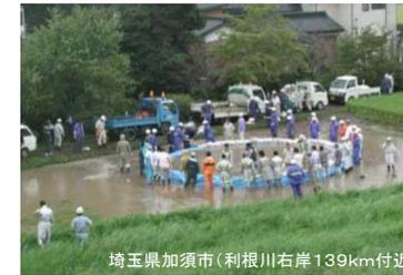
▲平成13年9月 台風第15号出水に伴う漏水状況
