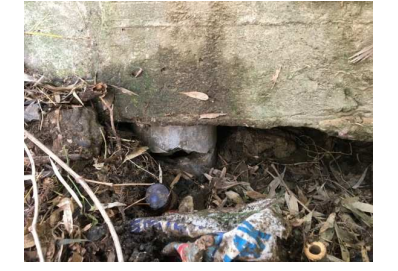
松ノ関橋 A1橋台ひびわれ
