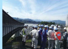
台風19号被害における災害復旧の様子（令和元年10月長野県東御市内）
