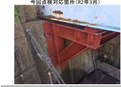
A1側主桁（仮受けブラケット設置）
