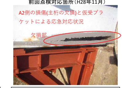
A2側主桁（腐食・断面欠損）
