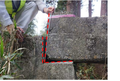
松ノ関橋 A1橋台傾斜
