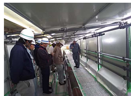
(橋梁修繕工事現場見学会の実施状況)
