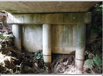
1径間 A1橋台ひびわれ
