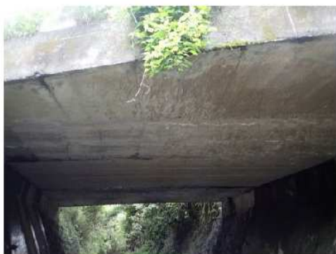
床版下面の状態
