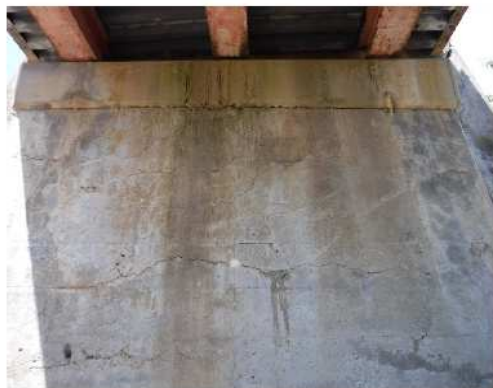
A1橋台堅壁のひびわれの状態
