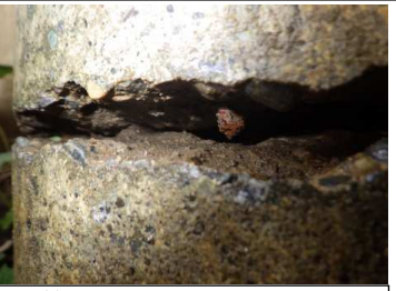
第一宮前橋 A1橋台破断
