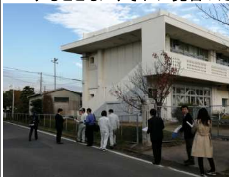
現地点検の様子
