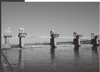
秋ヶ瀬取水堰。ここで取水された荒川の水が、埼玉・東京へ供給されています
