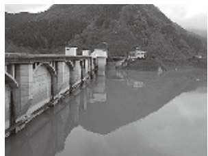
浦山ダム。荒川上流部のダム群などを効率的に運用して水の安定供給に努めています
