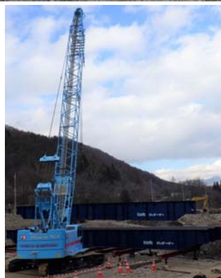
上部工架設作業①
