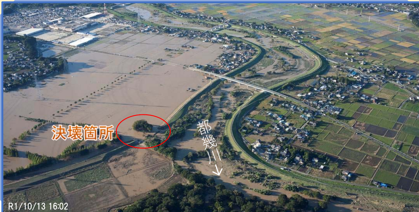
都幾川右岸0.4k付近（埼玉県東松山市早俣地先）の被災状況
