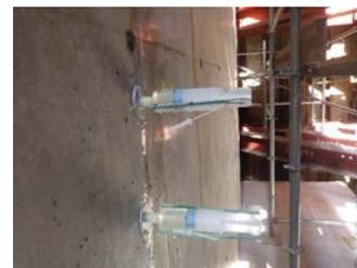
低圧低速注入工法による補修
