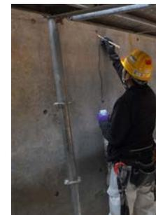
ひび割れ被覆工法(ケイ酸塩系)
