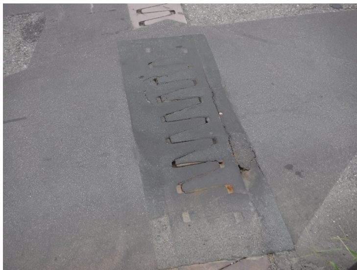
アスファルト系シートによる補修例
