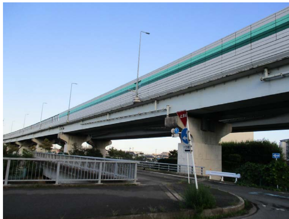
【設置状況写真】
