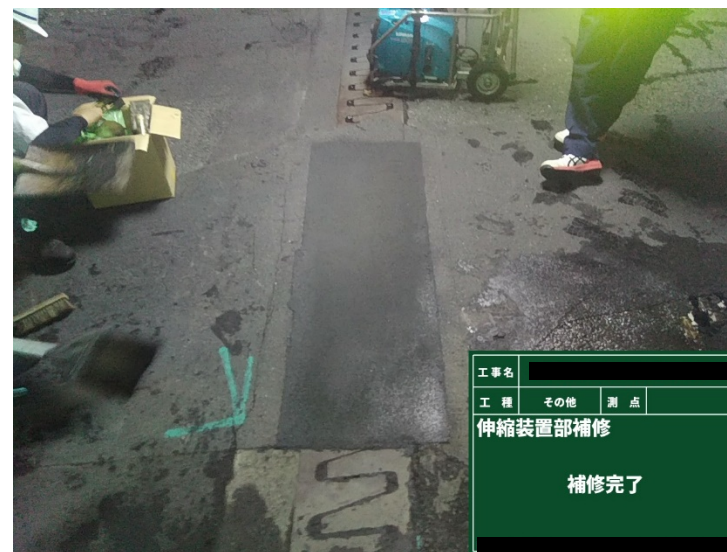
アクリル樹脂系路面補修材による補修例
