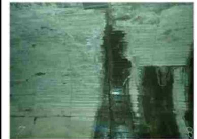
損傷状況(うき・漏水)
