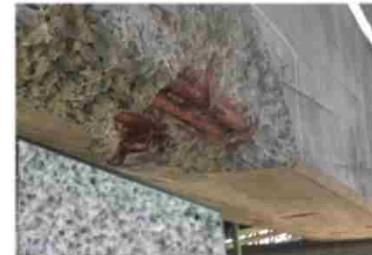
損傷状況(鉄筋露出)
