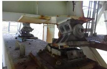
橋梁の支承・主桁の損傷
