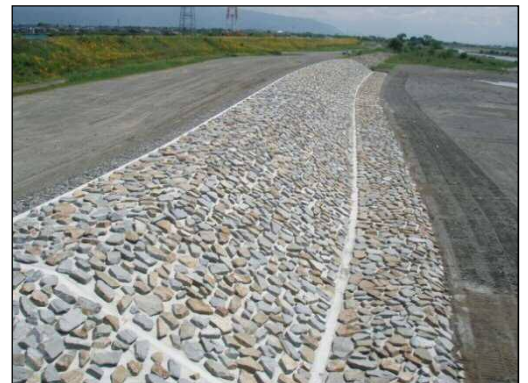
護岸整備（南アルプス市東南湖地先）
