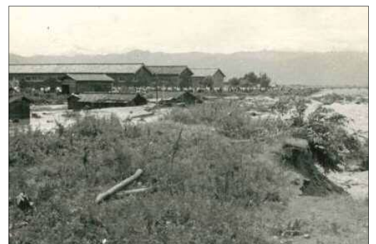
S34洪水 韮崎市武田橋付近の堤防決壊による浸水状況
