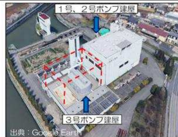
八潮排水機場(江戸川河川事務所)での例《外観》
