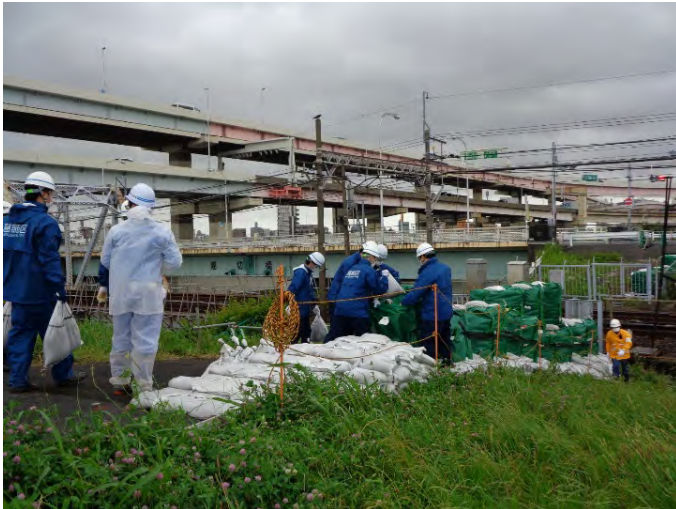
荒川左岸（葛飾区側） 土のう設置状況（R2年7月）
