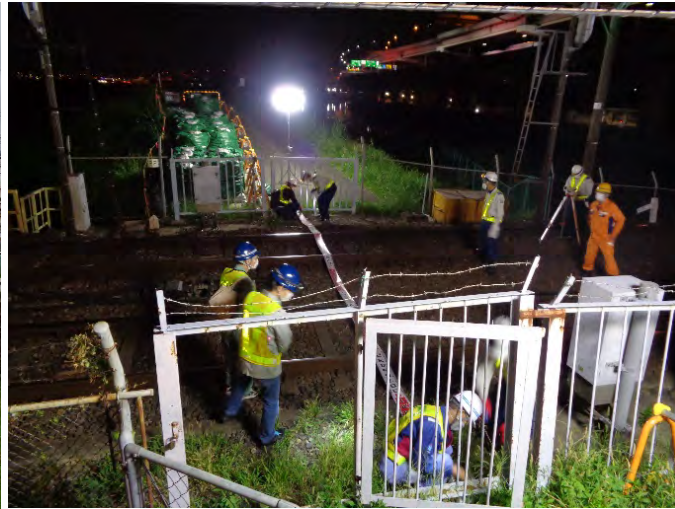
軌道内夜間現地調査 （軌道内の起伏・傾斜等の測量 を実施 R2年10月）葛飾区
