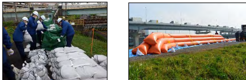
荒川左岸(葛飾区側)土のう設置状況
