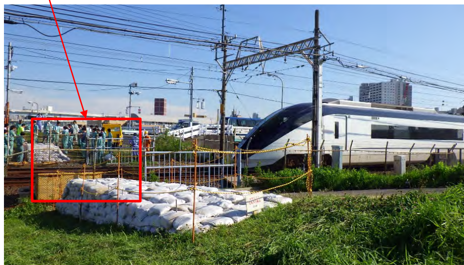
荒川右岸（足立区側）土のう設置状況（R2年7月）
