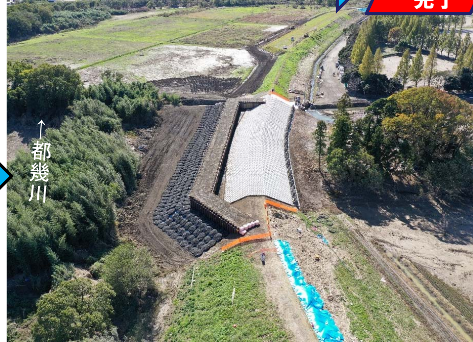
令和元年11月12日 緊急復旧完了後
