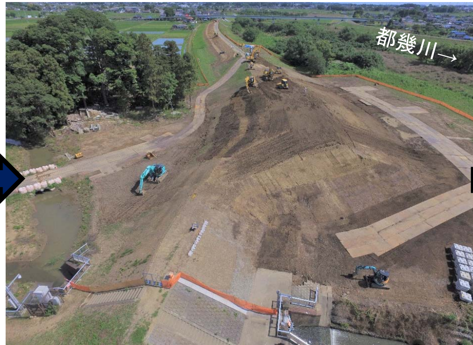
令和2年6月17日 堤防本復旧(盛土、法面整形)
