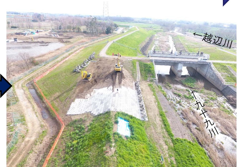
令和2年3月13日 緊急復旧施設撤去
