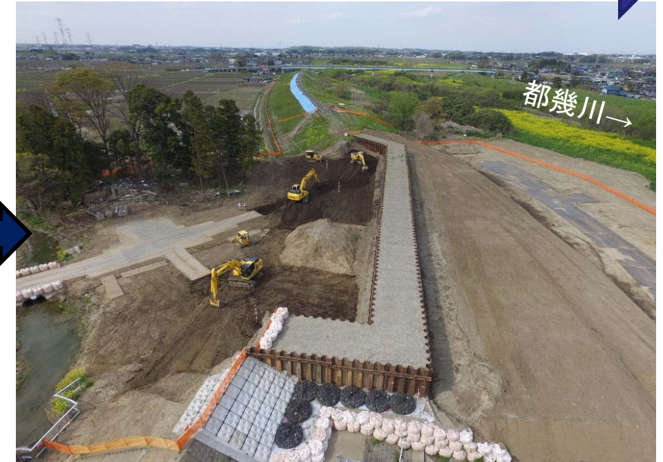
令和2年4月17日 堤防本復旧(盛土)
