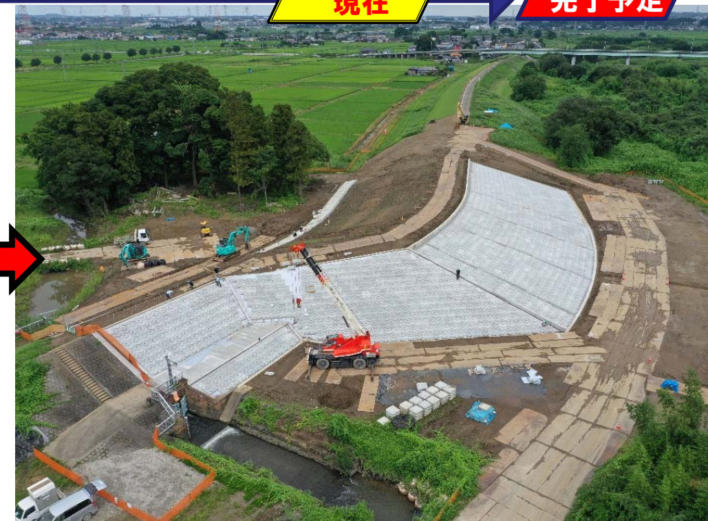
令和2年7月30日 護岸ブロック設置
