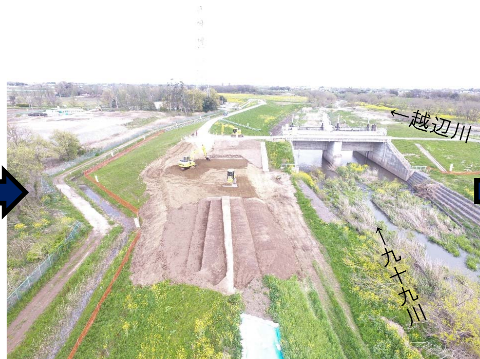
令和2年4月15日 堤防本復旧(盛土)
