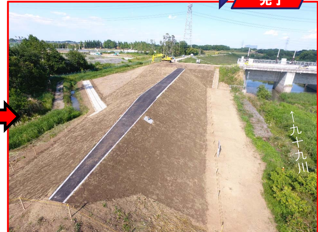
令和2年6月2日 堤防復旧完了
