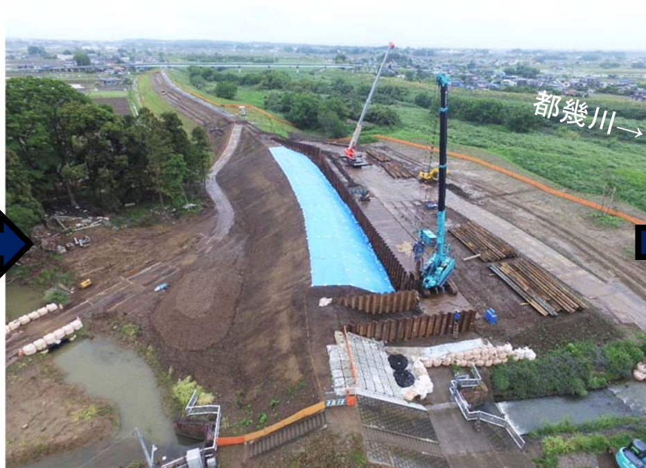
令和2年5月21日 緊急復旧施設(二重締切)撤去
