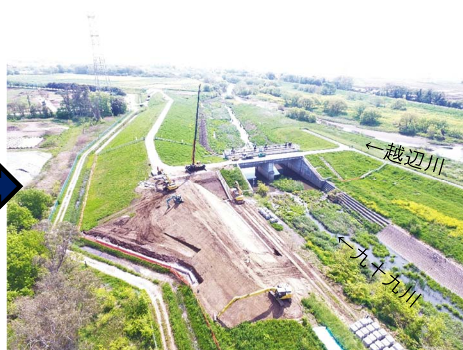
令和2年4月30日 堤防本復旧(法面整形)・基礎ブロック設置
