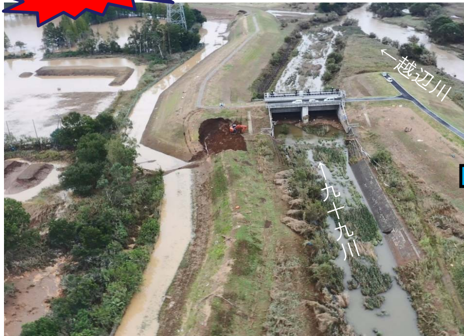
令和元年10月14日 被災状況
