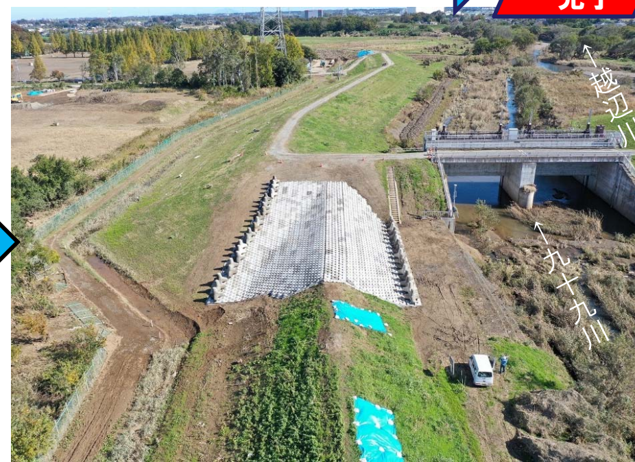
令和元年11月12日 緊急復旧完了後
