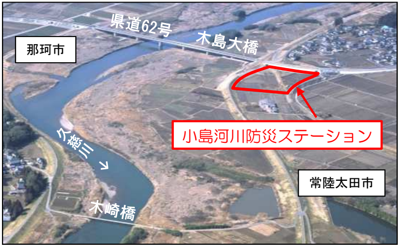
久慈川：小島河川防災ステーション
