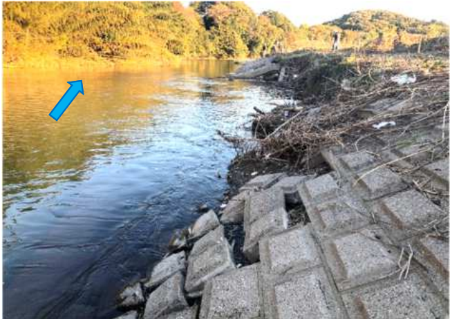
護岸が破損
