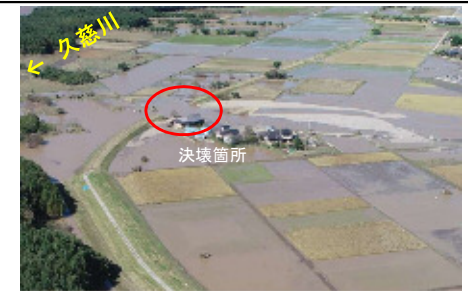
久慈川における浸水被害状況
