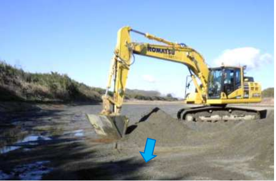
河道内の土砂掘削事例
