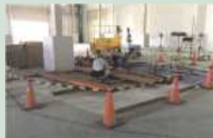
工事エリアの区画を設定して作業
